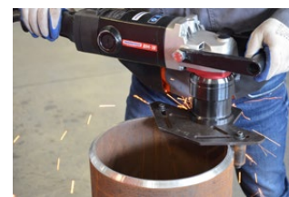
Afschuinen van buizen
